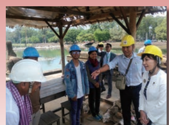
2019/10/9 アンコール・ワットにて橋の参道の修復工事への日本支援の様子を視察 (カンボジア)
